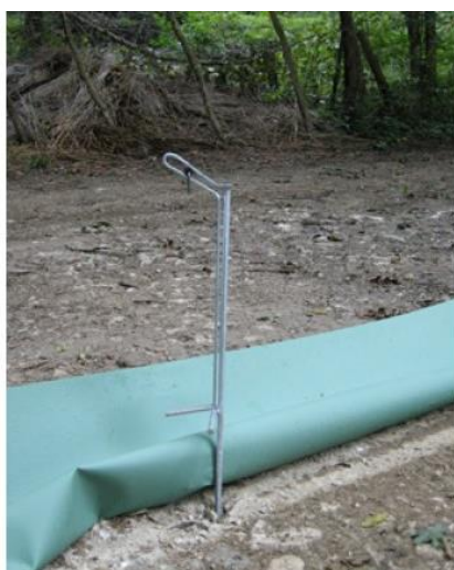
Figure 105 : Exemple d'une barrière avec bavolet et bâche lisse en cours de montage © M. Gigueux, Cerema Est
