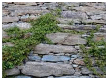
Figure 103 : Muret de pierres sèches (source : auJardin.info)
