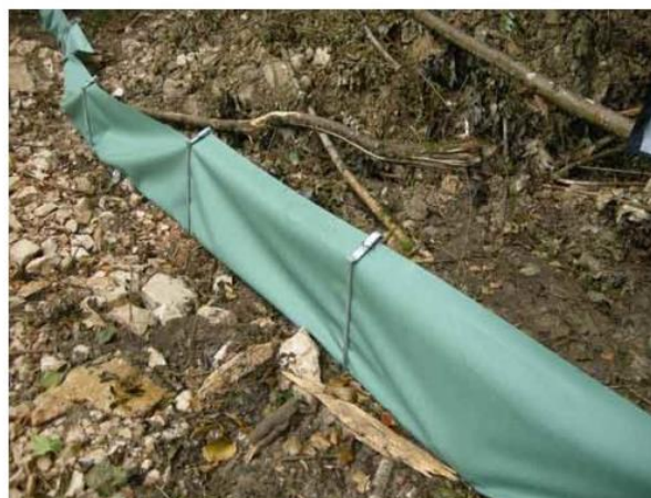
Figure 105 : Exemple d'une barrière avec bavolet et bâche lisse en cours de montage © M. Gigueux, Cerema Est
